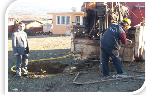
Foto 10. Zemin Etütlerinin Yerinde Kontrolleri Yapılırken
