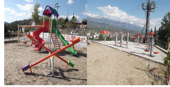
BELEN MAHALLESİ BELEDİYE PARKI 1 ADET OYUN GRUBU,1 ADET FİTNESS GRUBU MONTAJI ÇALIŞMASI TAMAMLANDI.
